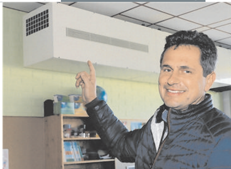
▲ Bürgermeister Andreas Nendwich ist zu Recht stolz darauf, dass eine moderne Lüftungsanlage in die Schulräumlichkeiten eingebaut wurde. Fotos: Rupert Kornell
